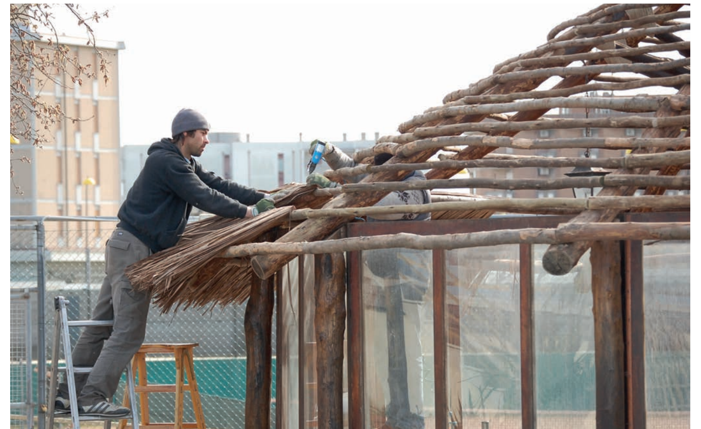
Fase 3: Fissaggio del materiale di copertura con rotolo o tegola / Step 3: Fixing of covering material, in rolls or tiles
