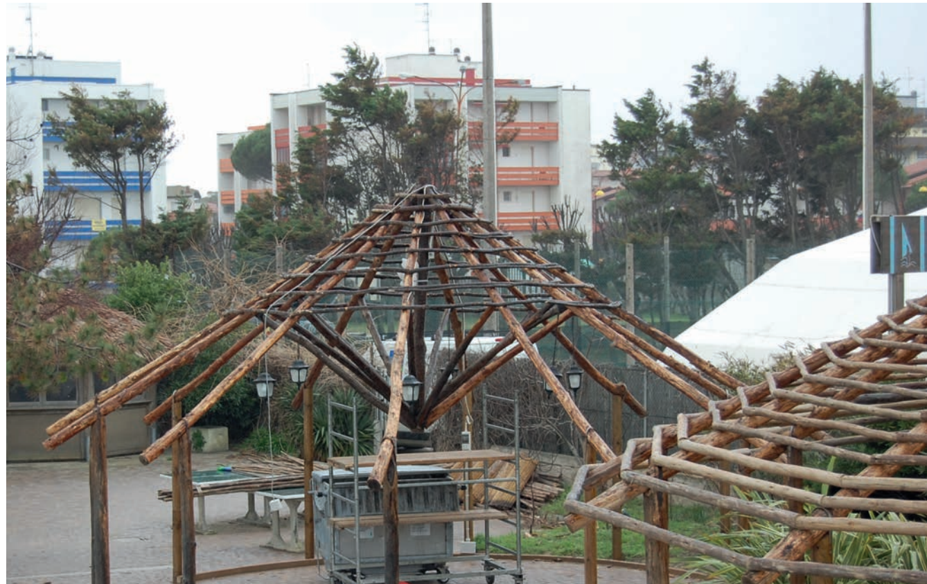
Fase 1. Realizzazione struttura primaria portante in Eucalyptus Sudafricano / Step 1: South african Eucalyptus Grandis main frame
